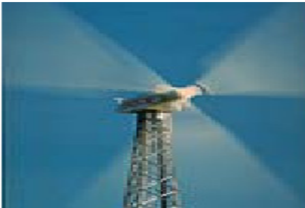
Torres de celosía
